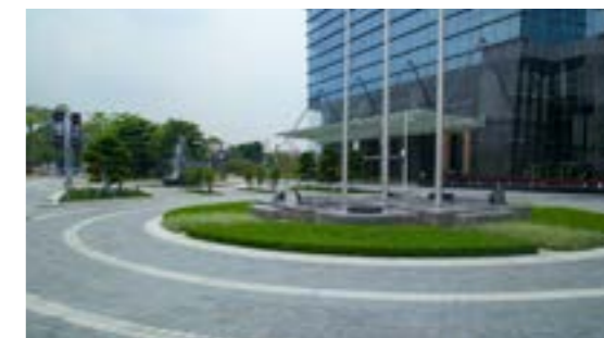
▲ 广州中交集团南方总部基地项目
